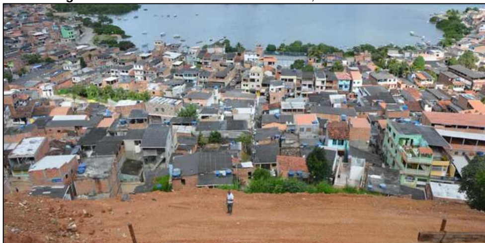
Figura 34 - Área de encosta em Plataforma, Subúrbio Ferroviário
